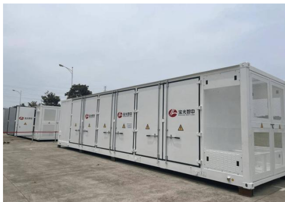
图释 02 – 储能电站之储能柜
